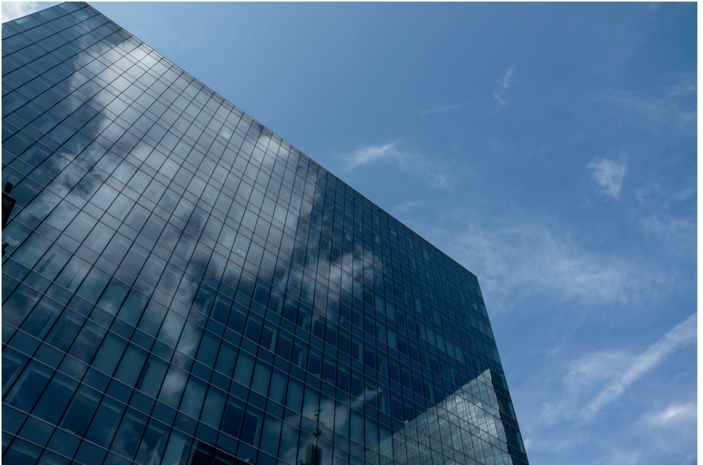
Crédit Agricole, Toulouse 2 thermofrigopompes Omicron Rev S4 13 centrales de traitement d'air double flux Gold RX
