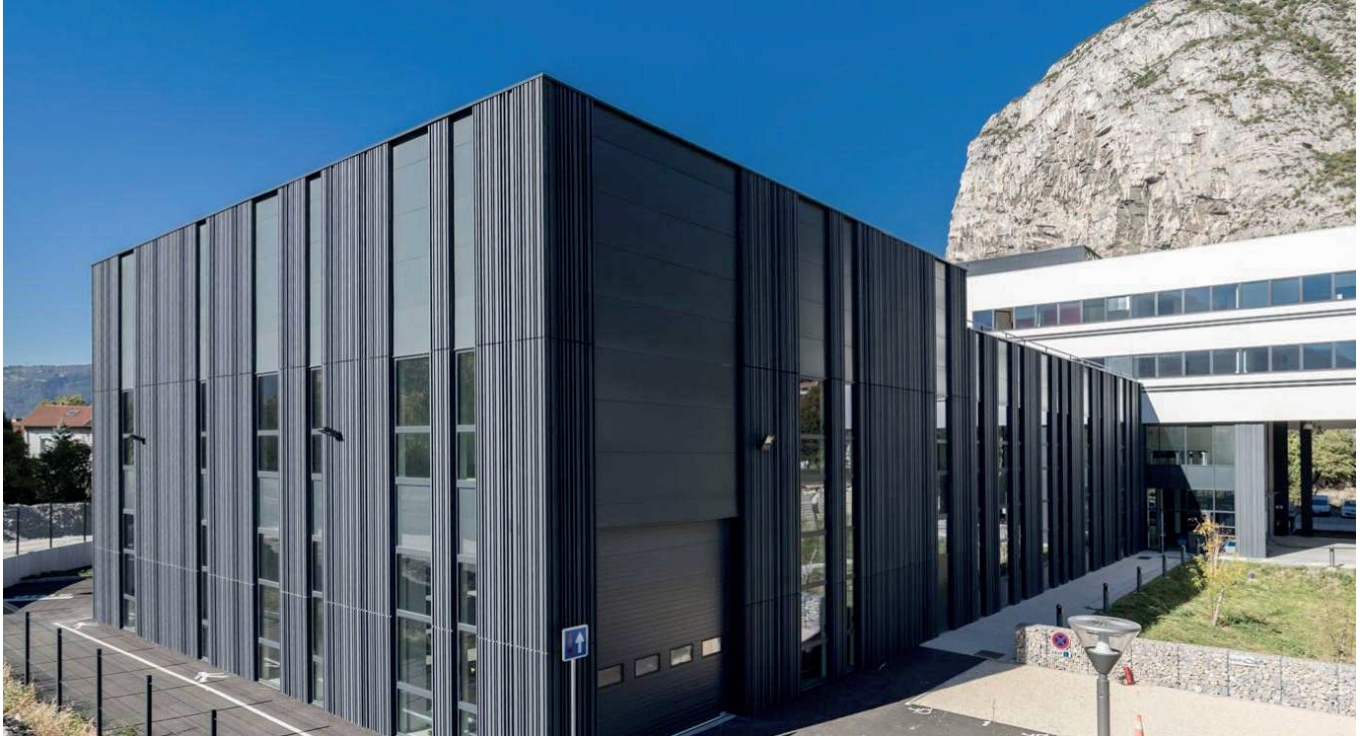
Pôle hydraulique, Saint-Martin-le-Vinoux 10 centrales de traitement d'air double flux GOLD RX 1 centrale de traitement d'air simple flux GOLD SD 3 thermofrigopompes OMICRON Rev S4 2 refroidisseurs de liquide BETA Rev RFE avec régulation Multilogic 1 refroidisseur de liquide EPSILON Rev 2 refroidisseurs de liquide ZETA Rev
