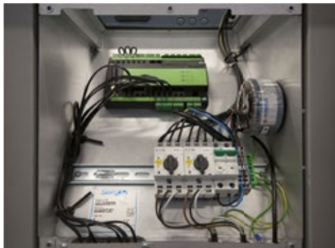
Tutte le apparecchiature elettriche e di controllo sono raccolte in uno speciale alloggiamento situato nella sezione centrale dell'unità di trattamento aria.
