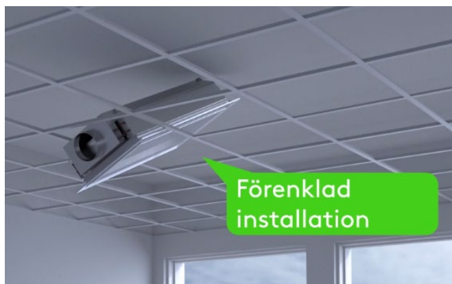
Figur 11. Installation i befintligt T-bärverk
