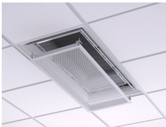
Figur 12. Demontering av underplåt för åtkomst av batteriet
